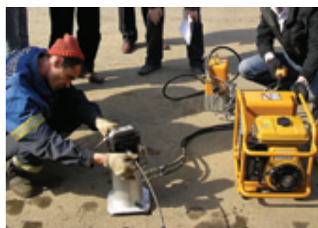
Пресс EP-60D и насосная станция HPE-4M. Опрессовка грозотроса ТК-70, зажим СВС-70-3.
