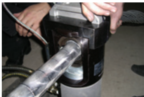
Пресс EP-60D. Опрессовка провода АС 300/39, зажим САС-300-1.
