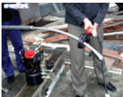
Резка провода АС-300/39 универсальным неавтономным резак SP-32
