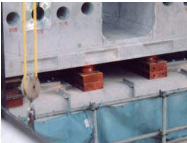
Низкий домкрат JFN200S3 с фиксирующей гайкой
