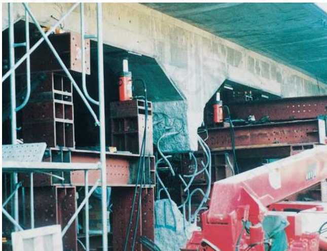
Гидравлический домкрат 1000кН и насос с электрическим приводом
