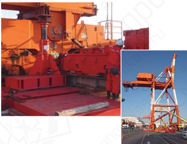
Гидравлический домкрат 5000кН, 500мм и электрическая насосная станция GH5-V2TFVF-P
