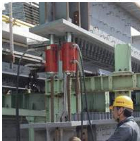
Домкрат гидравлический с полым штоком 1000кН
